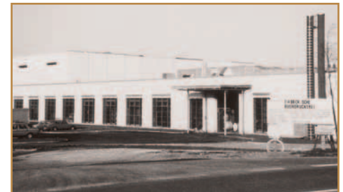
Der Neubau der C.H.Beck'schen Buchdruckerei in Nördlingen, Augsburgener Straße
